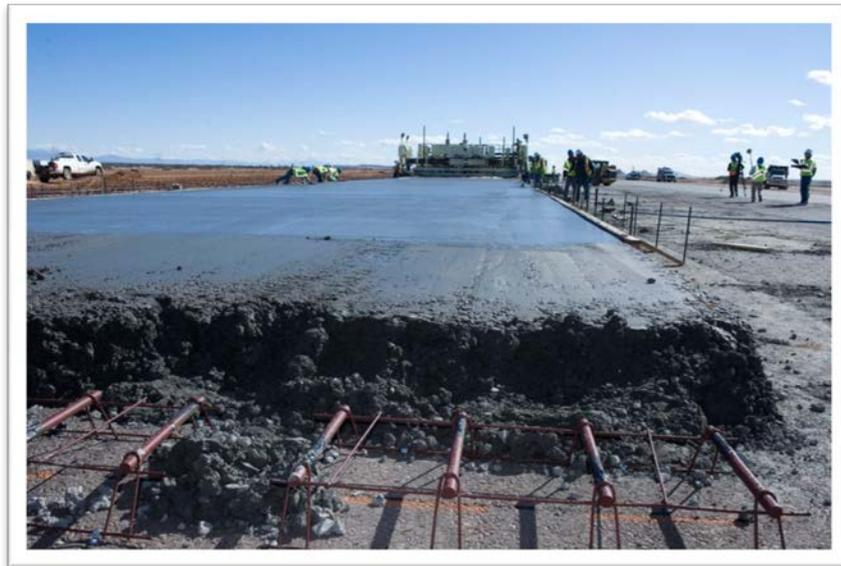
Figura 2-4 – Pavimento rígido em construção
