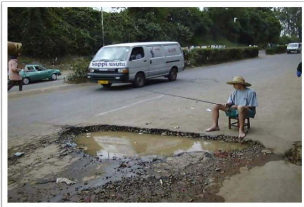
Figura 2-8 – Trincas em pavimentos podem evoluir para buracos
