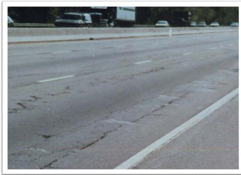
Figura 2-10 - Área trincada nas trilhas de roda
