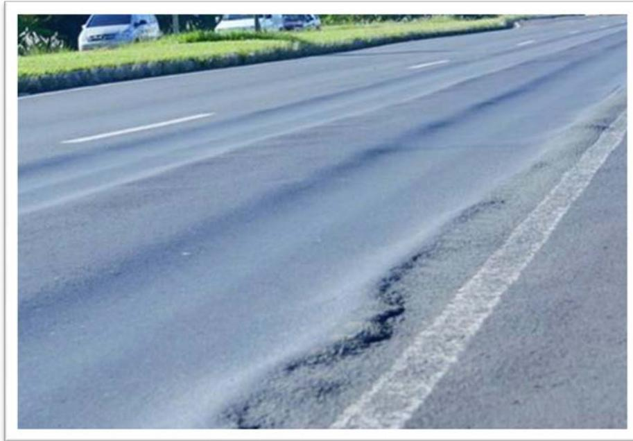
Figura 2-11 - Deformação permanente em rodovia
